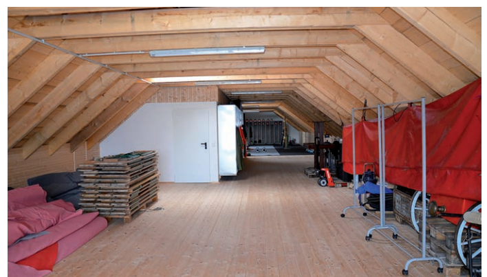
Neu geschaffener Stauraum im Dachboden
